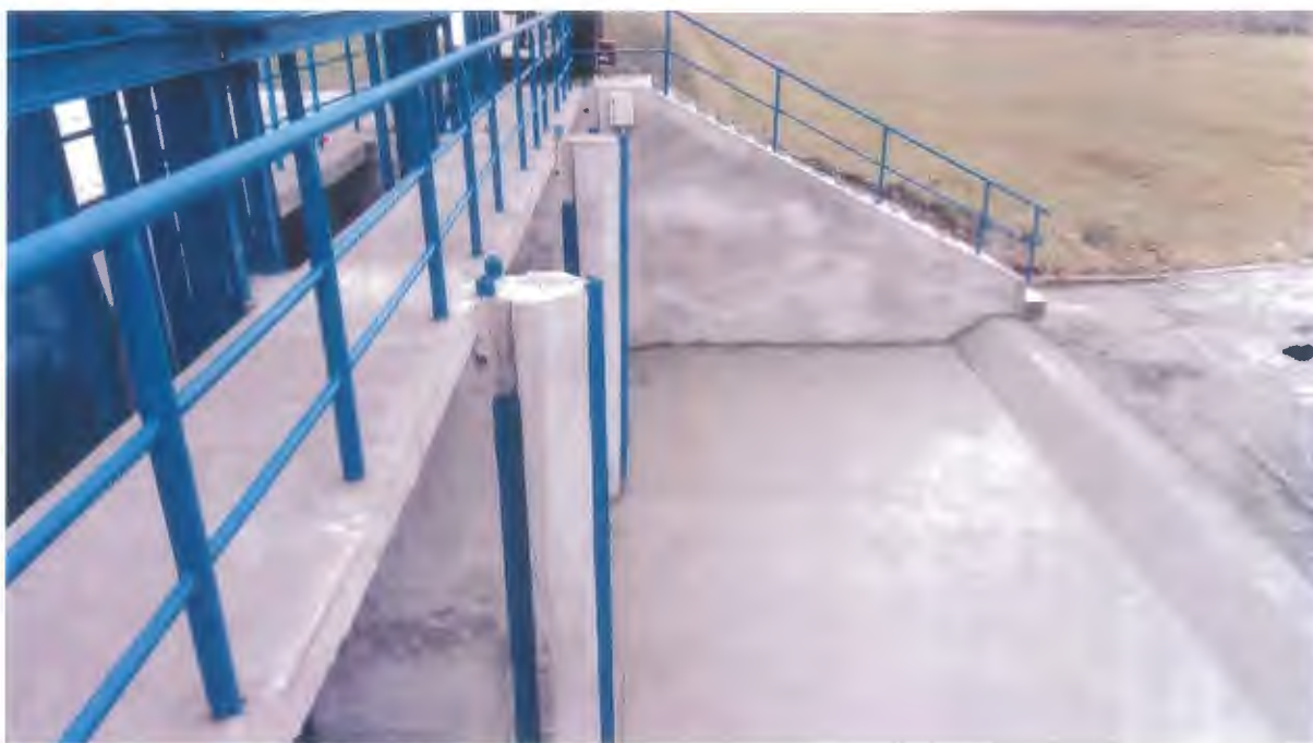
Rys. 1 Przykład jazu wyremontowanego przy użyciu zaprawy mineralnej REBET A
